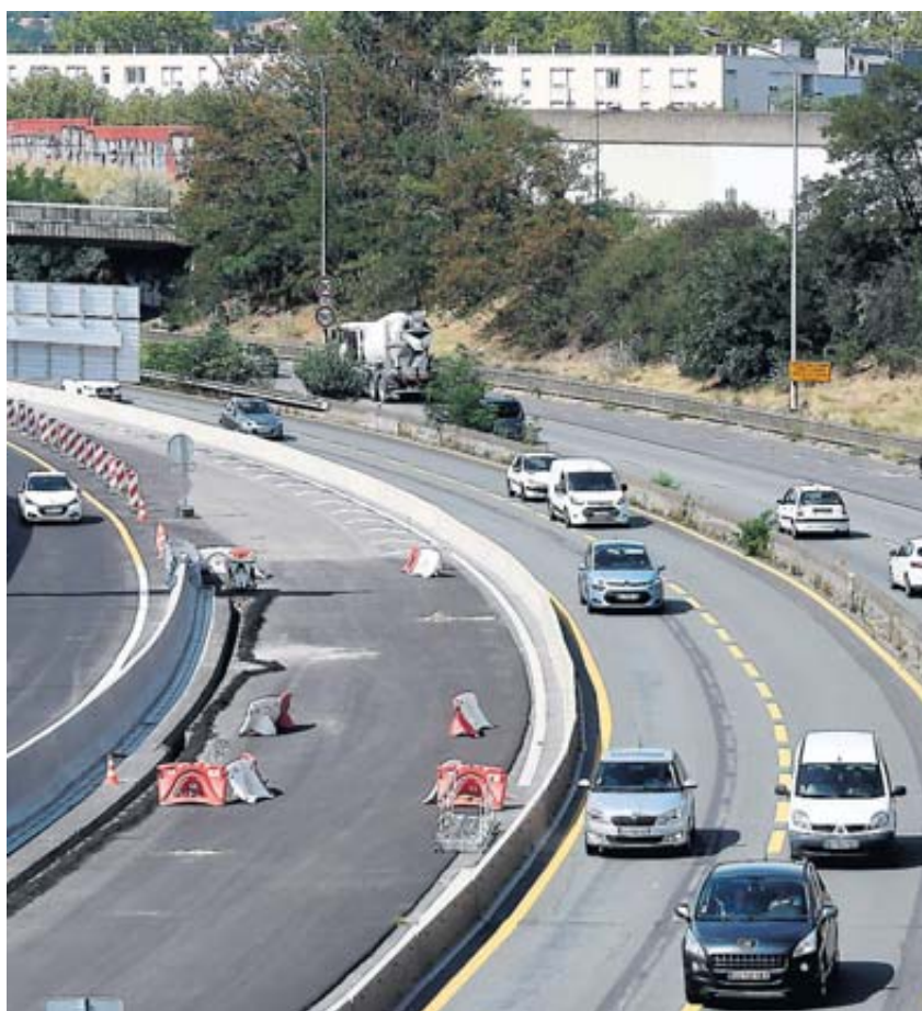
L'élargissement de la rocade à 2x2 voies avance. / DDM, Xavier de Fenoyl
