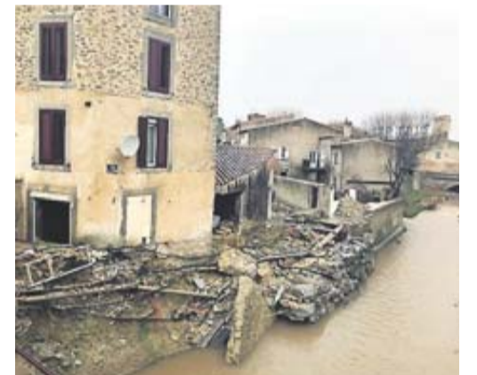
Le village est encore sinistré. / Photo DDM R.B.
