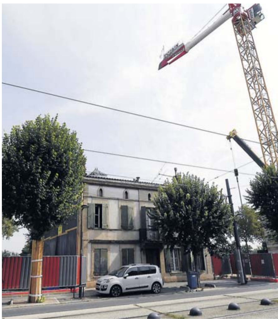
Les immeubles poussent tout autour de cette maison de maître./DDM, Michel Viala
