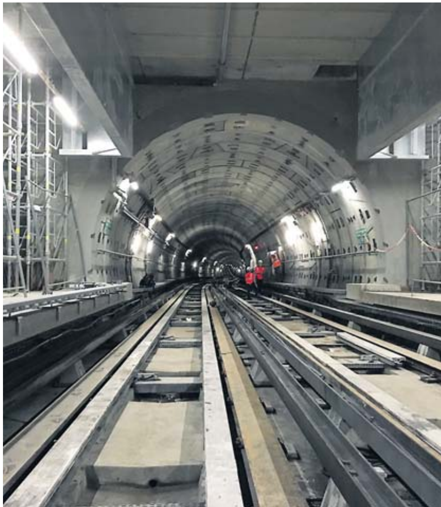
Pendant les travaux cet été, l'extension des quais. / DR, Tisséo Ingénierie
