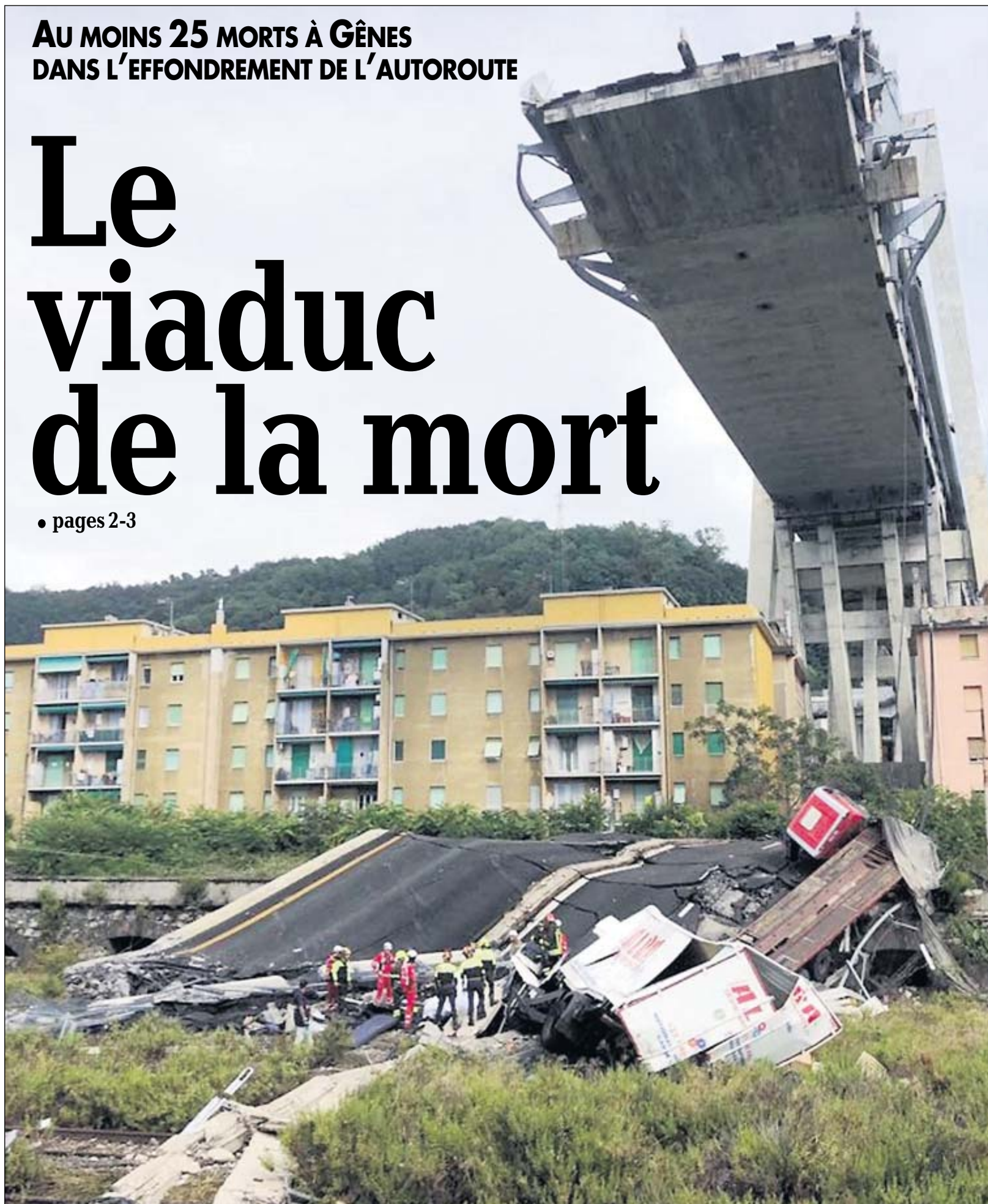
Dans un amas impressionnant de tôles et de béton, des centaines de secouristes fouillent les décombres, avec l'aide de chiens, à la recherche de survivants. /Maxppp
