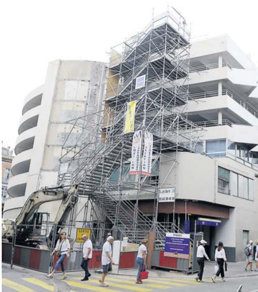
Les travaux ont démarré autour du marché Victor-Hugo. / DDM, Nathalie Saint-Affre
