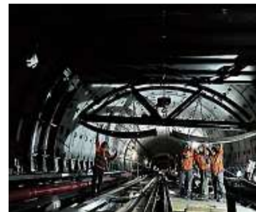
Installation des cintres métalliques hier à Patte d'Oie./Photo DDM, Fred Charmeux
