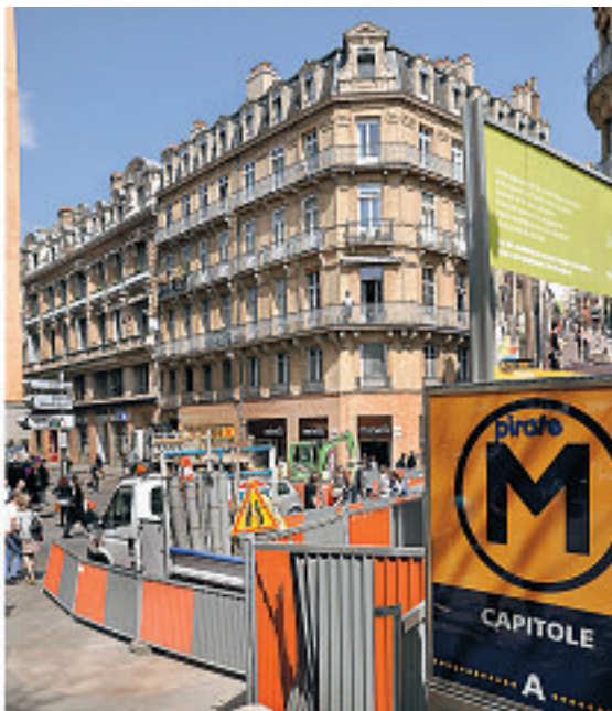
Le réaménagement de la rue Alsace, un des gros chantiers de l'été à Toulouse. / Photo DDM
